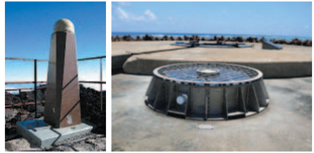
図9 設置場所の環境に適合した電子基準点形状（左図：富士山頂、右図：沖ノ鳥島） 9)
